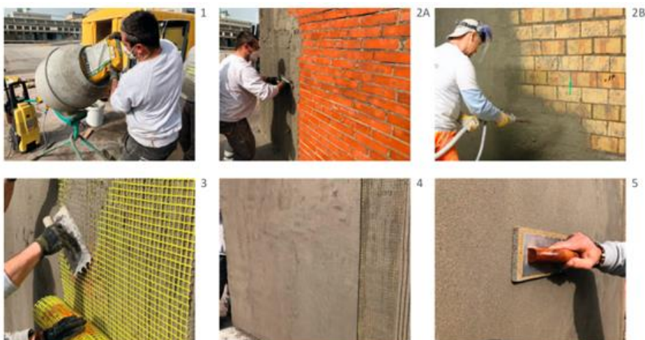
Slika 5: Redosled izvođenja FRCM ojačanje
