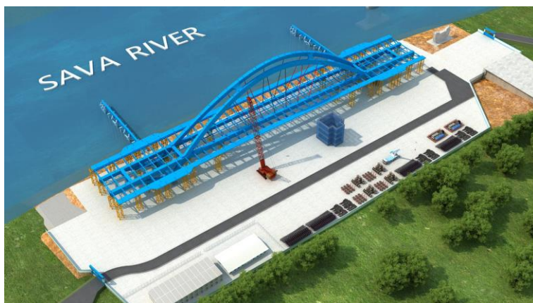
Slika 6: Izvođenje glavnog raspona-faza utezanja vešaljki
