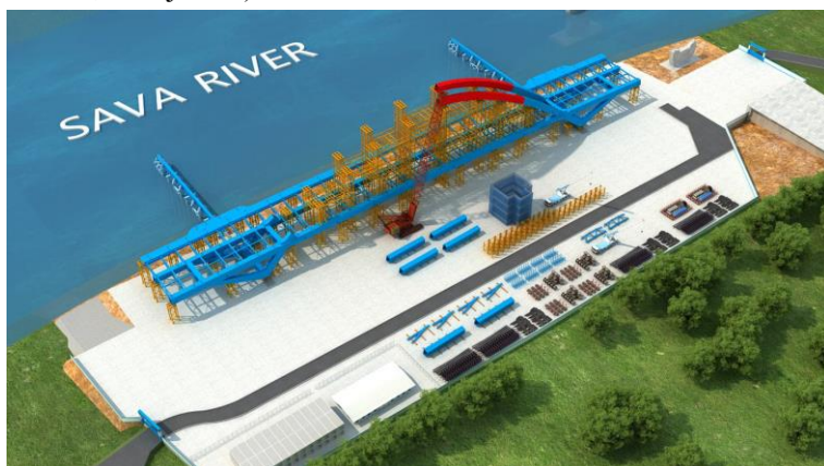
Slika 5: Izvođenje glavnog raspona-faza ukрупnjavanja lukova
