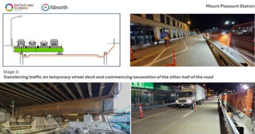
Slika 7: Faza 3 – transfer saobraćaja na izvedenu platformu
