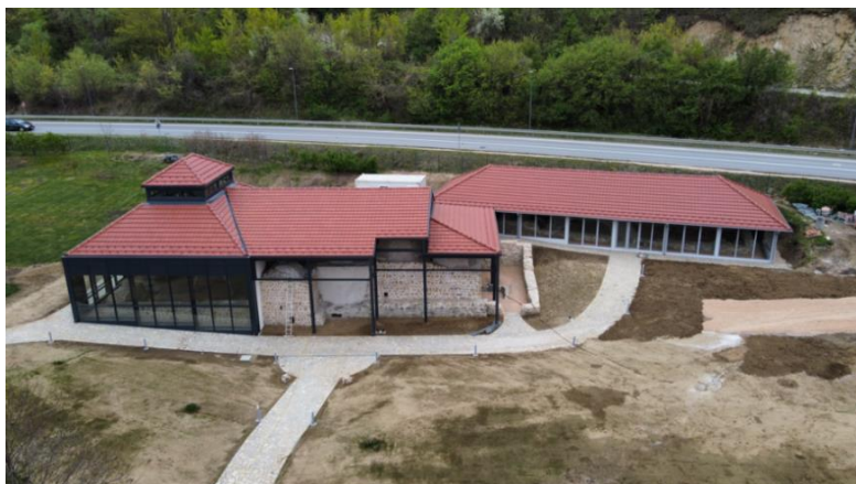
Slika 15: Turski hamam i Rimska kuća posle izvedenih radova na sanaciji i rekonstrukciji
