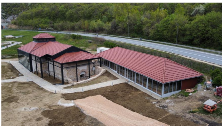
Slika 16: Turski hamam i Rimska kuća posle izvedenih radova na sanaciji i rekonstrukciji
