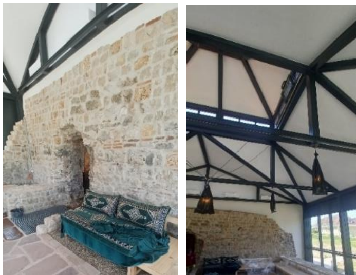
Slika 14: Unutrašnjost Turskog hamama posle izvedenih radova
