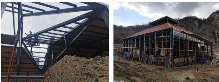
Slika 12: Izvođenje radova na čeličnoj konstrukciji i fasadi
