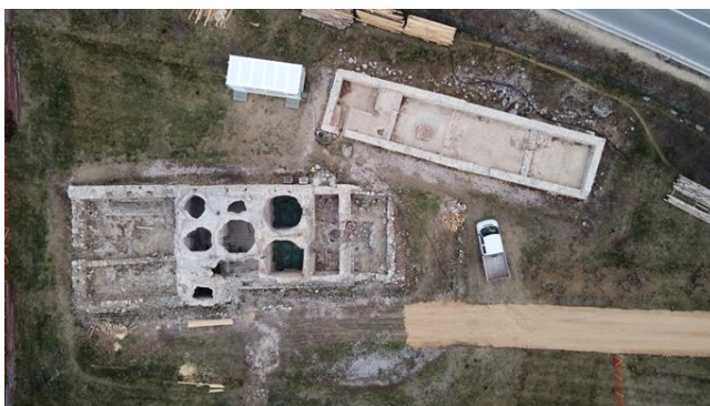
Slika 5: Rimska kuća i Turski hamam posle uklanjanja zaštitne konstrukcije
