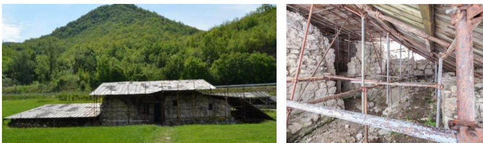
Slika 10: Privremena zaštitna konstrukcija Turskog hamama
