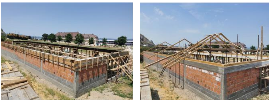
Slika 6: Izvođenje radova na sanaciji Rimske kuće
