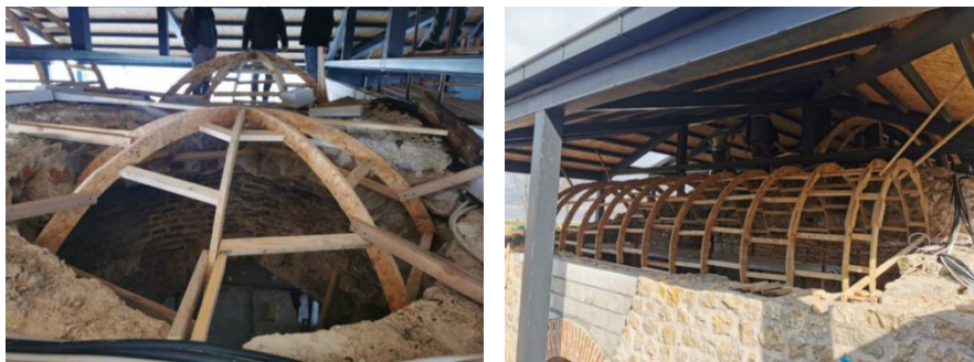
Slika 11: Izvođenje radova na kupli i svodovima
