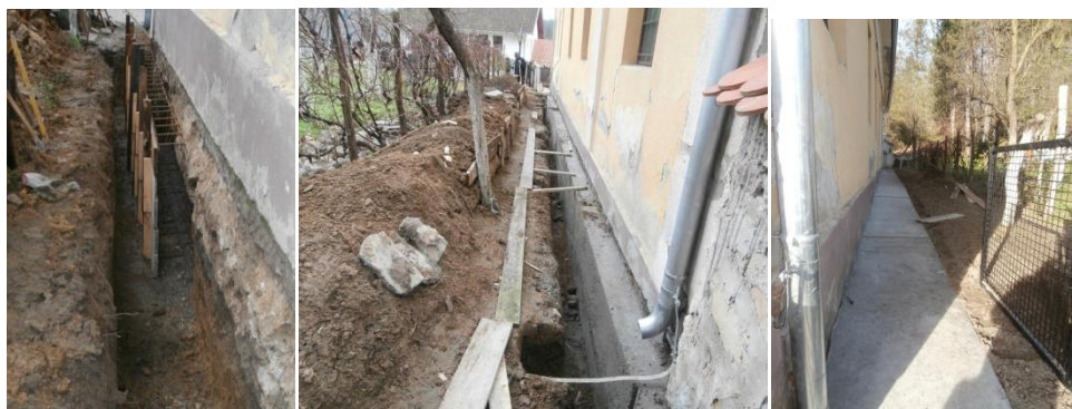
Slika 4. Fotografije sanacija i rekonstrukcija temelja objekta
