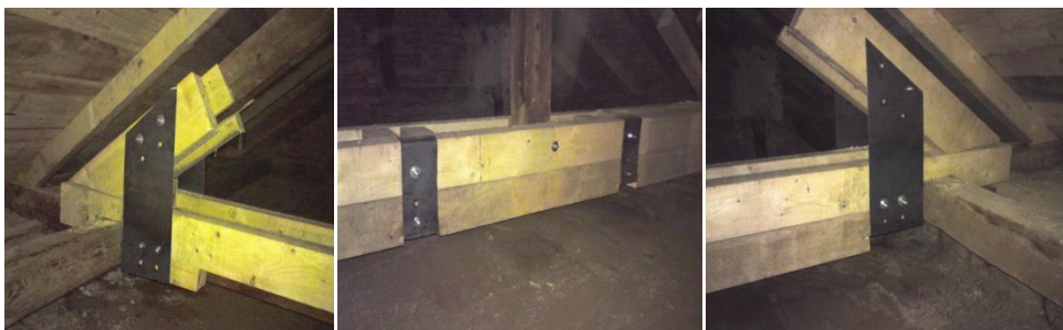
Slika 8: Fotografije sanacija i rekonstrukcija oštećene crvotočne zatege vešaljke br.15
