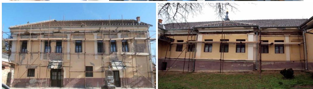
Slika 5: Fotografije sanacija i rekonstrukcija zidova objekta
