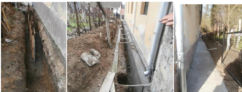
Slika 4. Fotografije sanacija i rekonstrukcija temelja objekta
