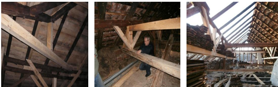
Slika 7: Fotografije sanacija i rekonstrukcija krovne konstrukcije
