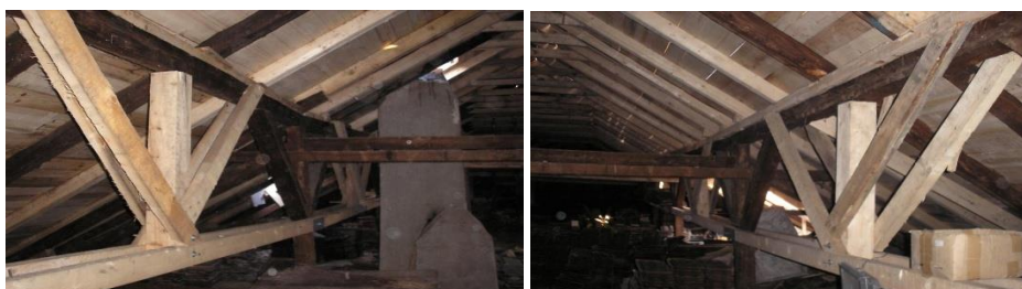
Slika 6: Sanacija krovne konstrukcije stvaranjem rešetki
