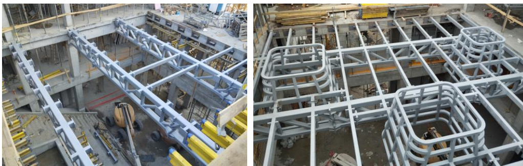
Slika 9: Montaža čelične krovne konstrukcije ulaznog hola
