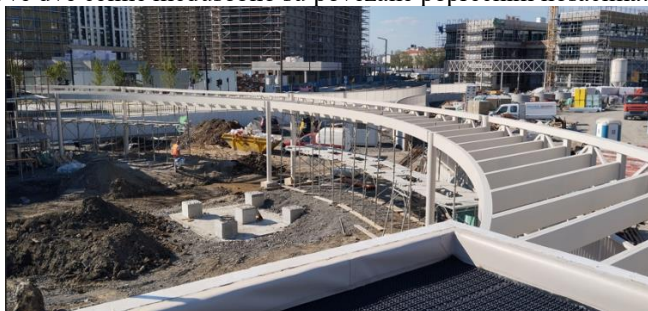
Slika 11 –Konstrukcija za nošenje pergola u fazi izvođenja
