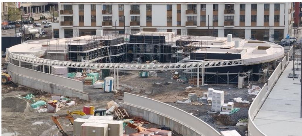
Slika 7: Armiranobetonska i čelična konstrukcija objekta vrtića u fazi izvođenja
