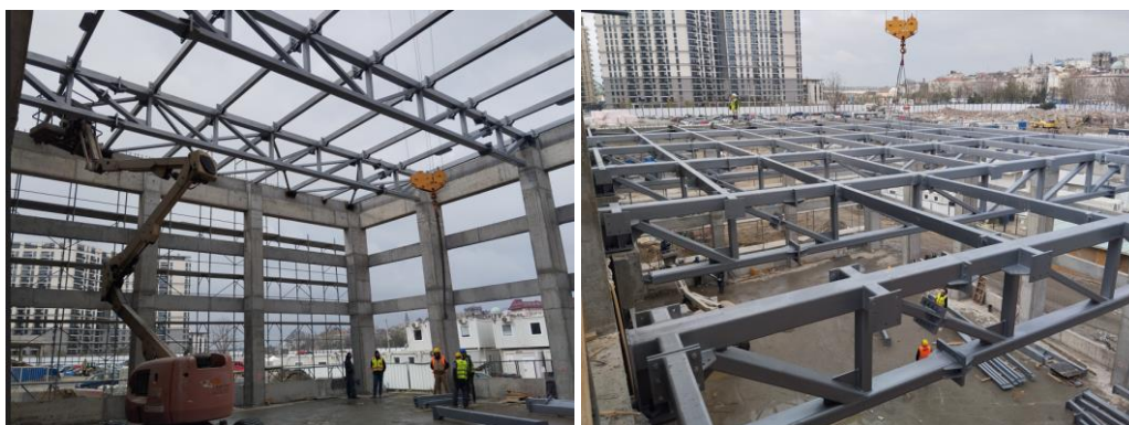
Slika 8: Montaža čelične konstrukcije krova fiskulturne sale
