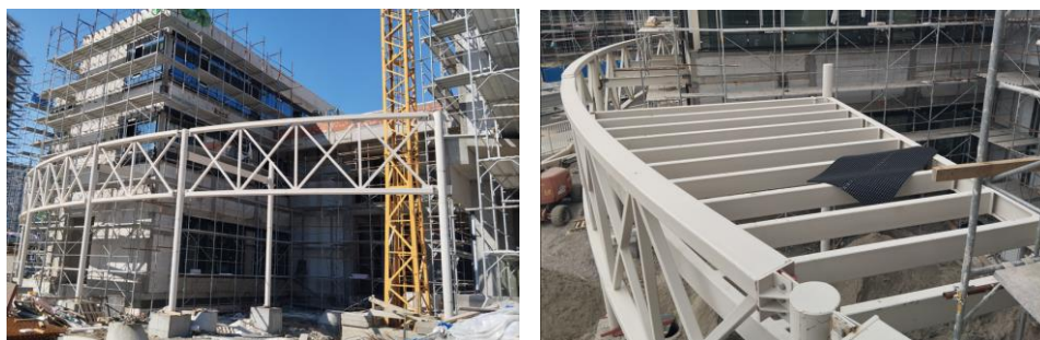
Slika 10: Konstrukcija za nošenje maske i pergola u fazi izvođenja
