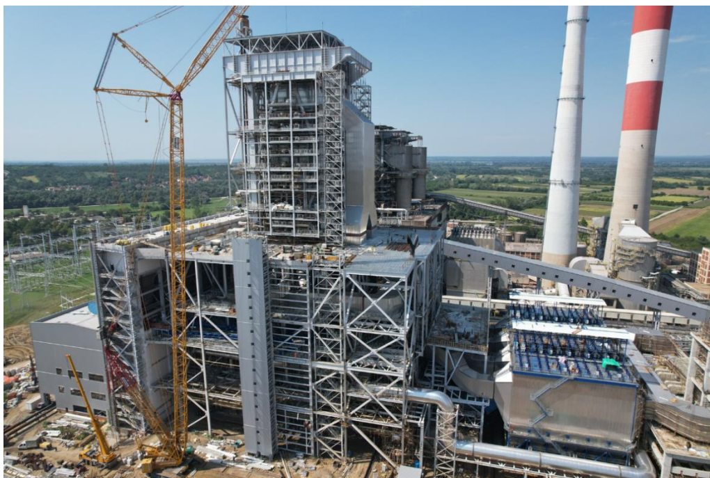
Slika 6: Objekat Kotlarnice u fazi izvođenja
