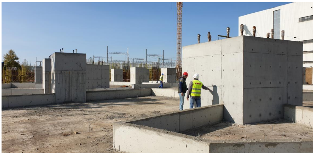
Slika 5: Temelj Kotlarnice nakon završetka izvođenja temelja
