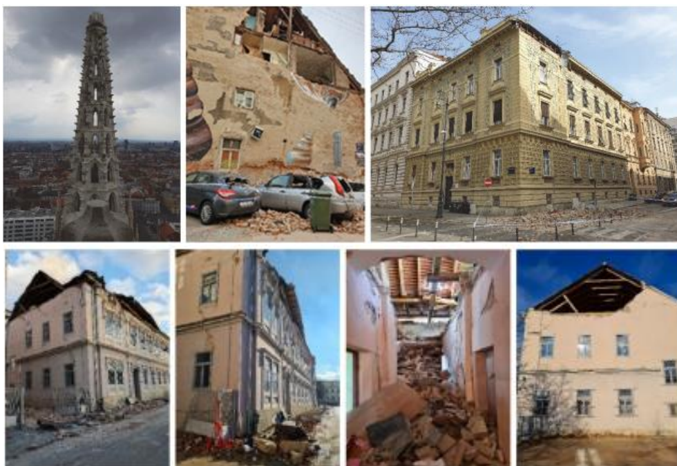
Slika 1: Oštećenja zidanih zgrada u Zagrebu i Petrinji
