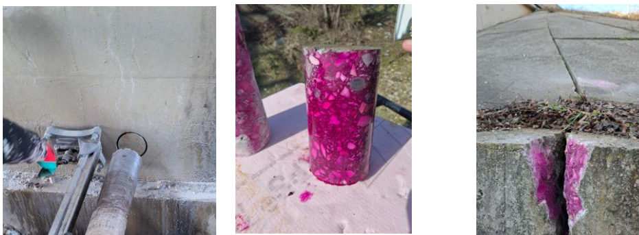
Slika 2: Terensko ispitivanje dubine karbonatizacije betona
