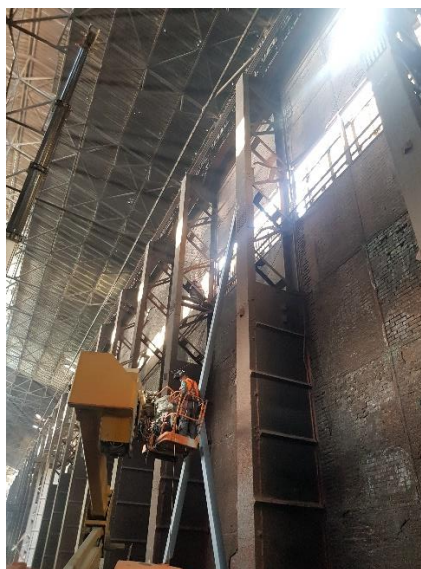
Slika 2: Ojačanje postojećeg objekta Hale konvertora sa rafinacijom – zavarivanje kutijastih profila
