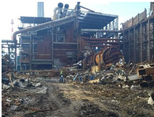
Slika 6: Prikaz Hale konvertora i rafinacije u toku izvođenja radova na rušenju sa prikazom cevovoda i instalacija
