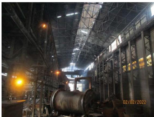
Slika 5: Hala konvertora izmedju osa A i B – glavni brod hale (pre rušenja)
