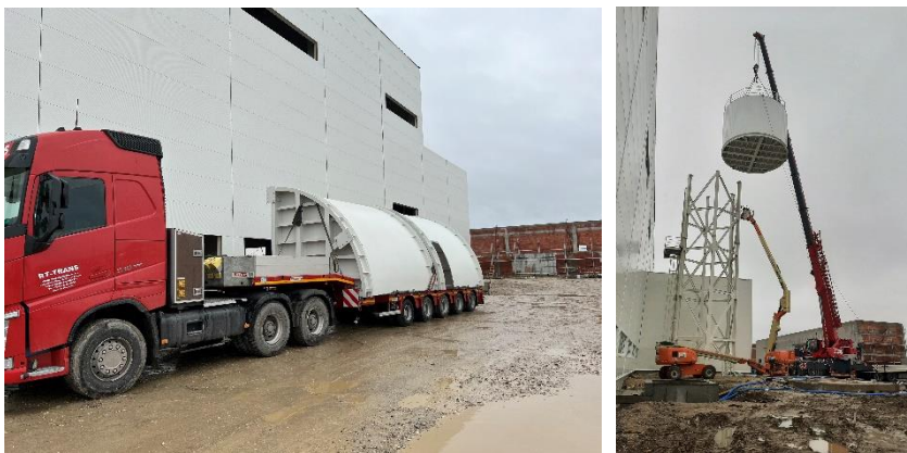
Slika 5: Transport segmenata rezervoara i montaža
