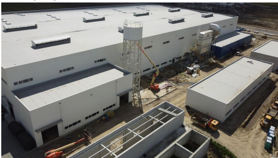
Slika 1: Vodotoranj u okviru fabričkog kompleksa
