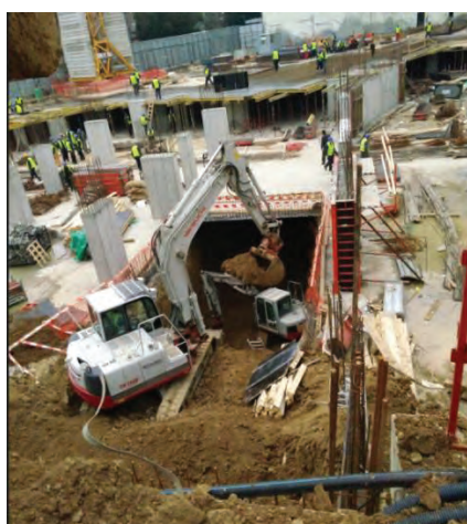
Faza top-down za Hotel Hilton, četiri podzemna nivoa
