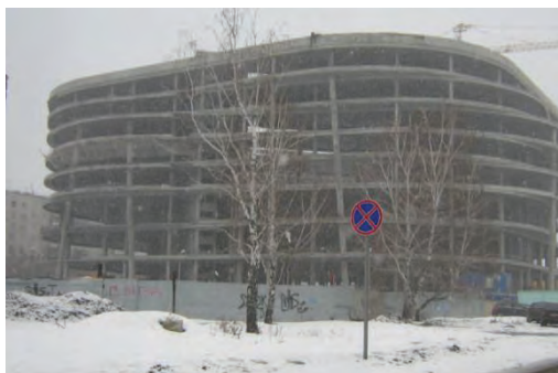
Teniski kompleks, Tjumen, Rusija, osnova po 100x100m, kroz 3, 4 i 5 sprat dva teniska terena sa tribinam, iznad toga tehnički prostori, iznad spa centri i teniski tereni na krovu, 3200 šipova
