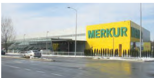
Merkur, Bežanija, montažna betonska i čelična konstrukcija
