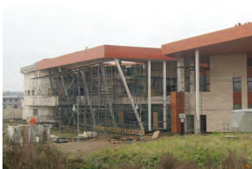
Komercijalni objekat, Tverska ulica, Moskva
