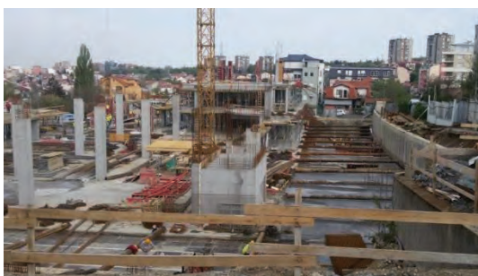
Aviv park, Zvezdara, faza izgradnje i razupiranja
