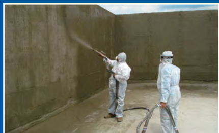
SANACIJA I ZAŠTITA
