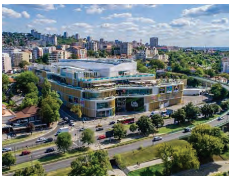
Ada Mall (tehnologija izvođenja, zaštita iskopa, deo konstrukcije sa CMS biroom)
